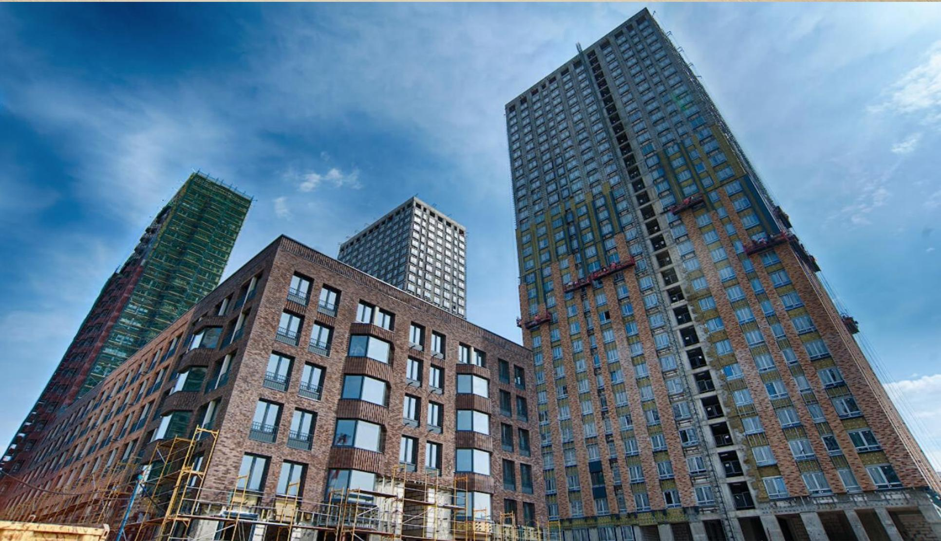
Облицовка бетонными плитками под кирпич и декоративными элементами из стеклофибробетона.
